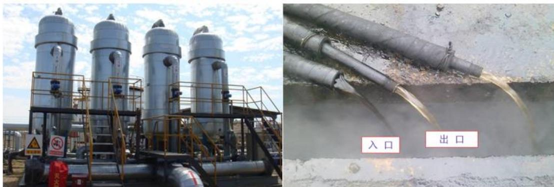
14000 方/天超稠油污水旋流聚结处理装置
