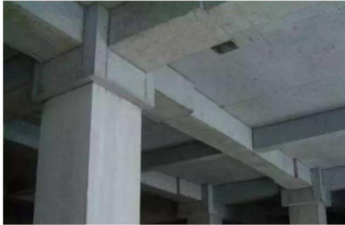
图 3 某建筑结构中的再生大骨料自密实混凝土梁
